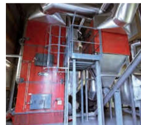
Hackschnitzelheizung mit Lagerraum und Rührwerkaustragung (li.), bei Platzmangel bietet sich der Anschluss ans Nahwärmenetz an (re.).
